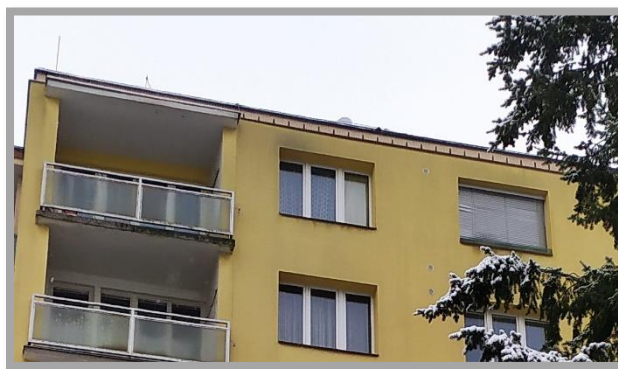
Obrázek č.1. - (Vletové otvory do atikového prostoru)
