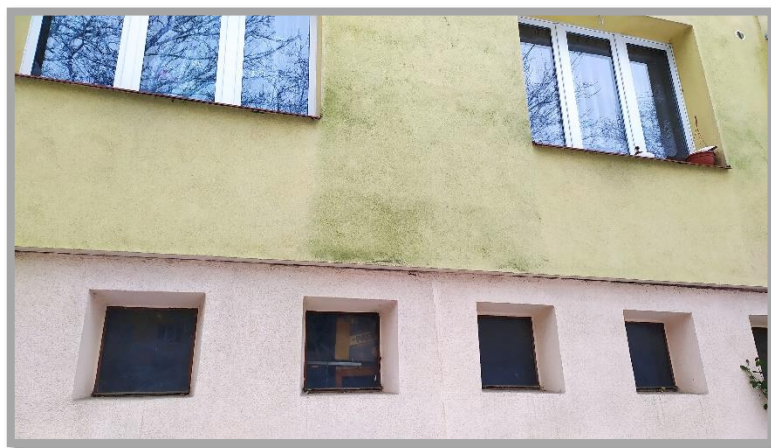
Obrázek č. 1 : (Napadení fasády řasou)
