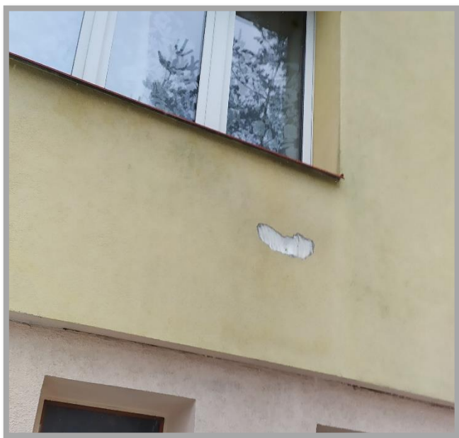
Obrázek č. 2 : (Lokální poškození fasády)
