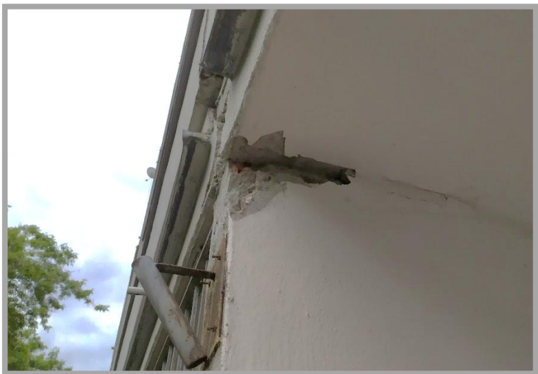
Obrázek č.3.: (Porušení povrchové vrstvy na bočních lodžiových panelech)
