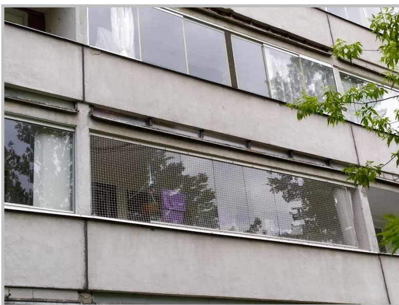
Obrázek č. 10: (Bezrámové zasklení lodžii)
