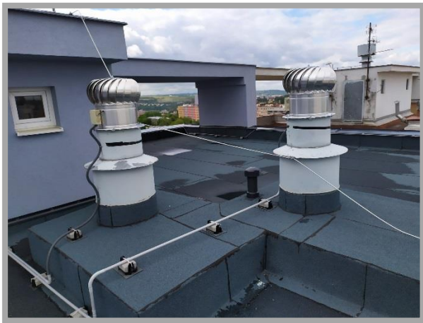
Obrázek č. 14 : (Stávající ventilační hlavice Lomanco na střeše objektu)
