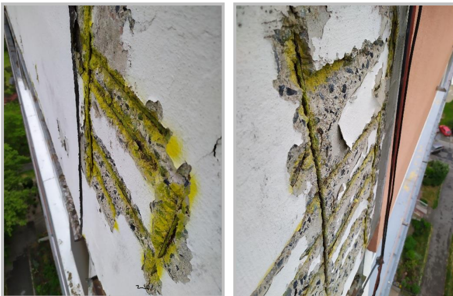
Obrázek č. 9: (Poruchy krycí vrstvy na žb. zábradlí lodžii)
