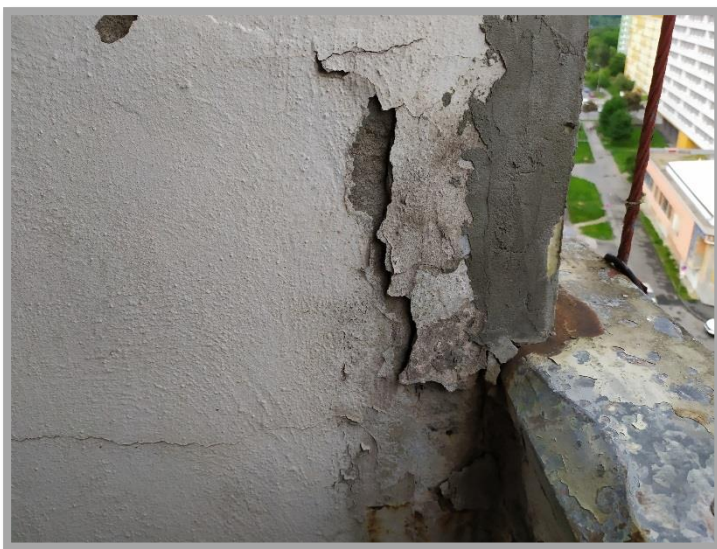
Obrázek č.3.: (Porušení povrchové vrstvy na bočních lodžiových panelech)
