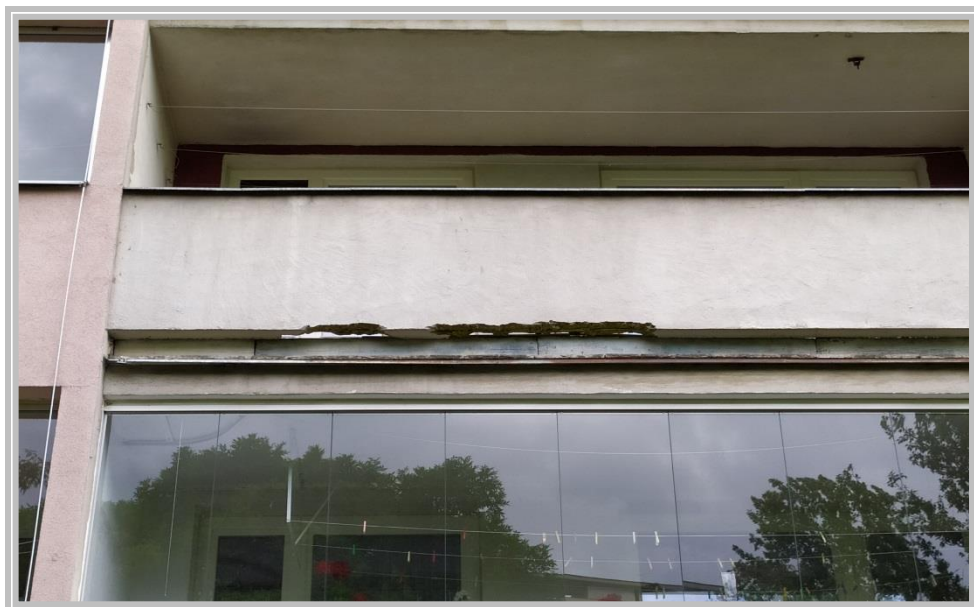
Obrázek č. 8 : (Poruchy konstrukce žb. zábradlí lodžii)
