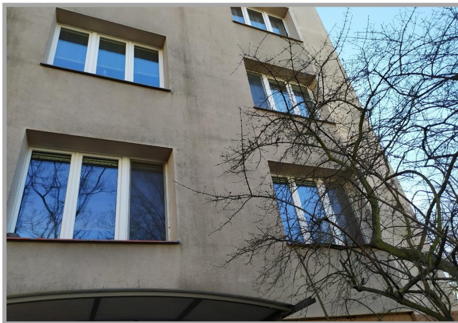
Obrázek č. 1: (Napadení fasády řasou)
