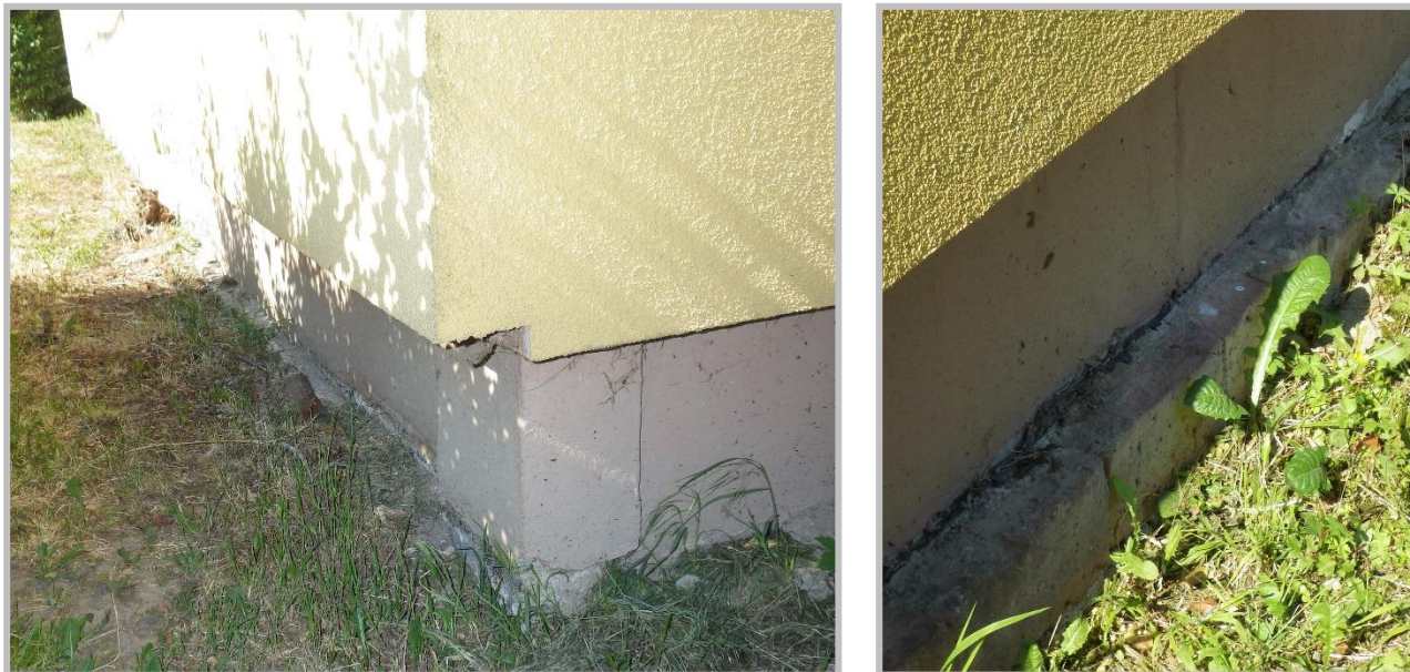
Obrázek 7 a 8: Stav stávajícího okapového chodníku / ukončení hydroizolace
