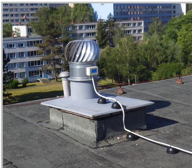
Obrázek č. 5 a 6 : Ventilací turbína + ukončení kanalizace
